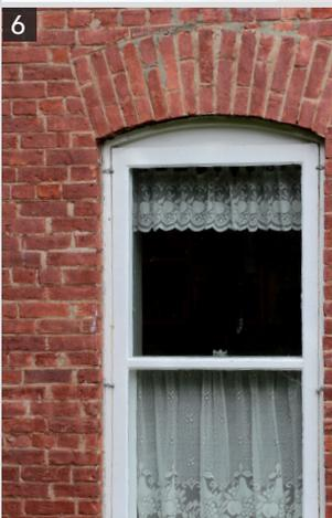
Briques en soldat surmontant la partie supérieure de la fenêtre.
