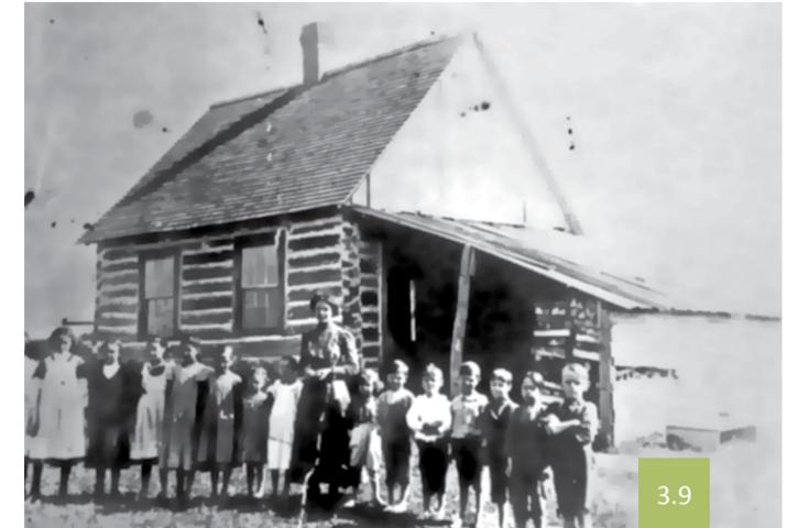
3.9 Exemple d'un type d'école construit au 19<sup>e</sup> siècle avec une structure en pièce sur pièce. Dans ce cas-ci, il s'agit de l'école du rang 10 du canton de Clifton, en 1912. Source : *Sainte-Edwidge de Clifton, 1885-1985*. p. 112.
