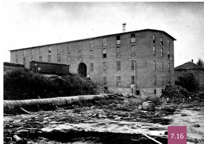
**7.16** Au moment de la construction de l'usine en 1902, une ouverture a été prévue dans le bâtiment pour permettre l'entrée des wagons à partir de la desserte ferroviaire, du côté de la rue Dominion. Source : © BAnQ, notice n° 2727783 [en ligne]
