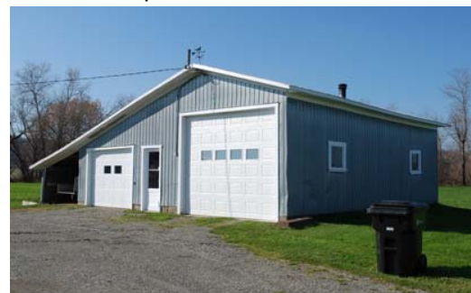
Garage s'intégrant mal à un ensemble ancien en raison de son toit asymétrique, son parement de tôle et ses portes industrialisées.
